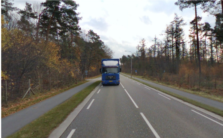
Afbeelding 3.2; Traject B, beperkte wegbreedte i.c.m. enkele asstreep en onvoldoende obstakelvrije ruimte
